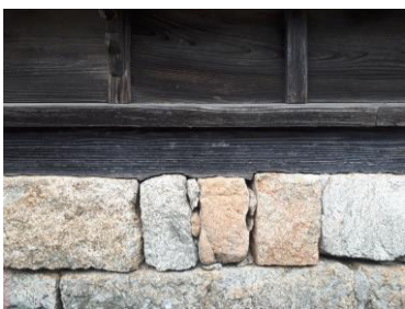
柱や土台を基礎の石の 凸凹の形に合わせる技法
